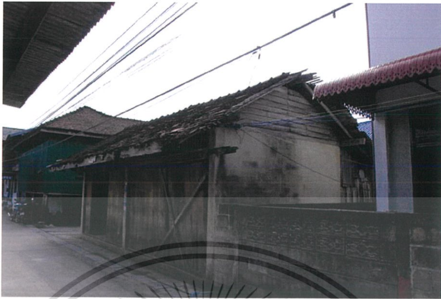
ภาพที่ 2.17 แสดงอาคารแถวค้ายายในชุมชนบ้านลำป่า มีการใช้ผนังก่ออิฐฉาบปูนเข้ามาร่วม ทางเข้าเป็น บานเฟี้ยมทำจากไม้แผ่น ที่มา : ผู้วิจัย
