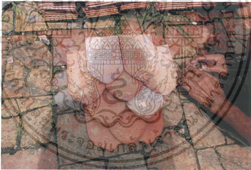
ภาพที่ 2.12 แสดงตัวอย่างวิธีการมุงกระเบื้องจากกระเบื้องที่ทำการเผาเรียบร้อยแล้ว
