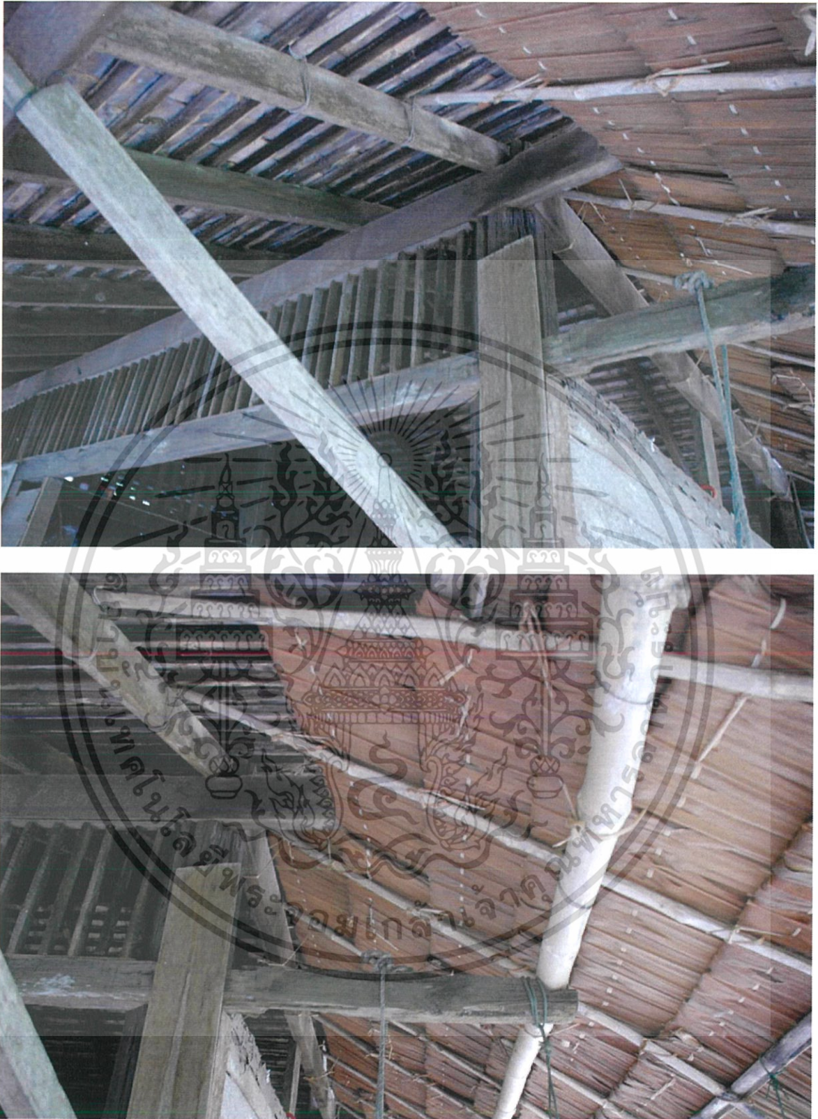
ภาพที่ 4.9 - 4.10 แสดงโครงสร้างหลังคา ลักษณะการมุงกระเบื้อง และชายคาที่ต่อเสริมออกไป
