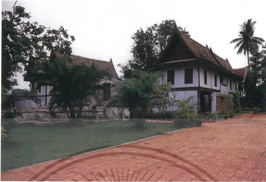
ภาพที่ 2.21 แสดงวังเจ้าเมืองพัทลุงเก่าที่ลำป่าหลังจากการบูรณะซ่อมแซมโดยกรมศิลปากร โดยใช้ กระเบื้องเกะยอ ที่มา : บริษัทยูโนแคลไทยแลนด์ จำกัด, 2541
