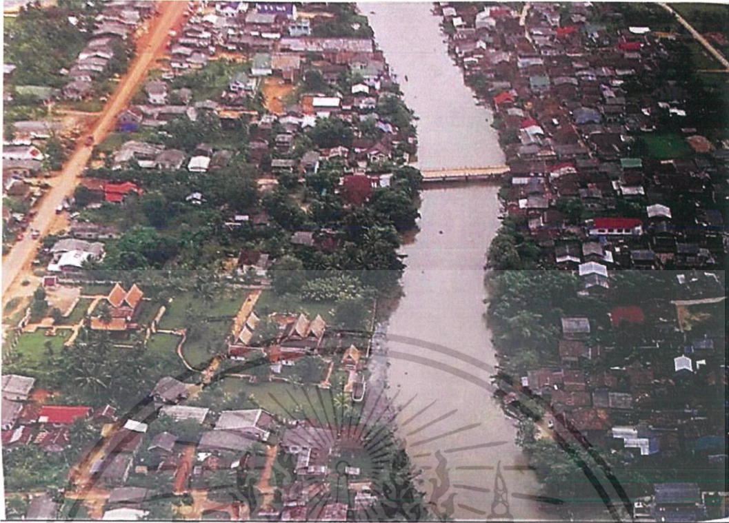
ภาพที่ 2.28 แสดงภาพมุมสูง แสดงลักษณะที่ตั้งของชุมชนบริเวณสองฝั่งคลองลำป่าและชุมชนบ้านท่าน้ำ ห้วนอนทางฝั่งขวาในภาพ เห็นถึงลักษณะบ้านเรือนที่ใช้กระเบื้องเกะยอยู่หนาแน่น กลุ่มอาคารทรงไทย 2 กลุ่มทางฝั่งซ้ายของคลอง คือ จวนเจ้าเมืองพัทลุงเก่า หลังได้ทำการบูรณะซ่อมแซมแล้ว ที่มา : บริษัทยูไนเต็ดไทยแลนด์ จำกัด, 2541
