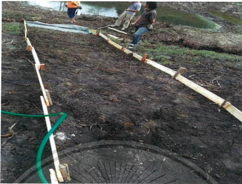
รูปที่ 3.6 เตรียมพื้นที่สำหรับการทดลองโดยติดตั้งกำแพงกั้นน้ำออก
