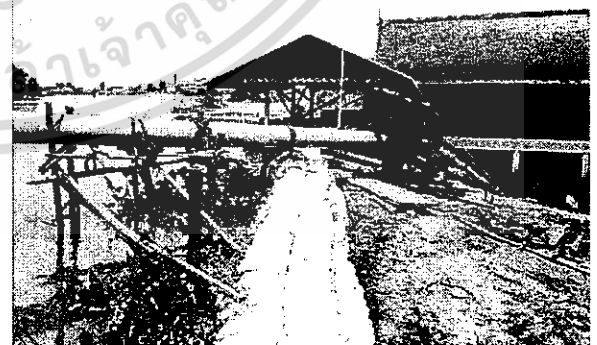
ภาพที่ 4.13 ภาพน้ำซึมจากด้านแม่น้ำน้อยเข้าภายในวัด ต้องใช้เครื่องสูบช่วยสูบน้ำออก
