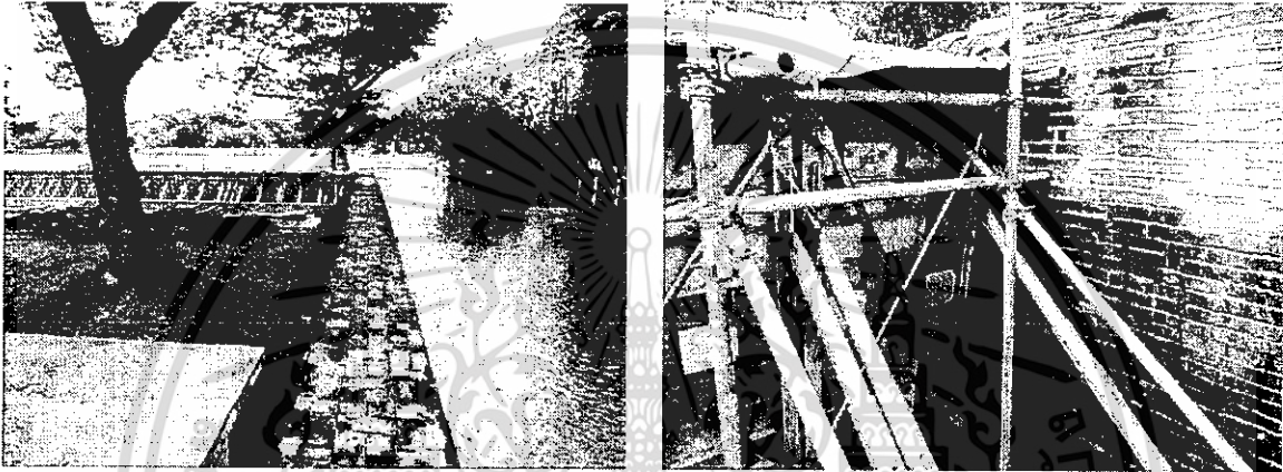
ภาพที่ 4.2 ภาพรอยต่อระหว่างเชื่อนแผ่นสแตนเลสกับกำแพงศิลาแลงจะมีน้ำซึมเข้าตลอดเวลา
