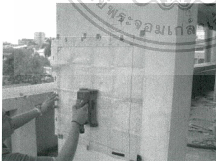
5.แสกนหาขนาดและปริมาณเหล็กเสริมเสา
