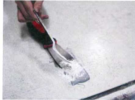
ภาพที่ 3.48 ภาพการผสมแมกนีเซียมไลท์
