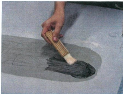
ภาพที่ 3.35 ภาพลุดกาวด้วยแปรงขนกระต่าย
