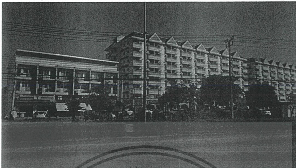
รูปภาพที่ 6-28 มุมมองจากหน้าบริเวณที่ 2 มองไปยังทิศใต้ของพื้นที่ ที่มา ถ่ายจากสถานที่จริงเมื่อ 30 พฤศจิกายน 2559
