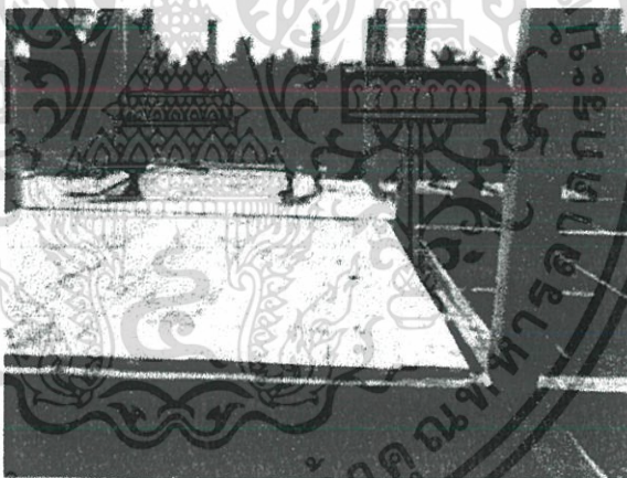
ภาพที่ 7-9 ภาพแสดง โครงสร้างของพื้นแบบสำเร็จรูปวางบนคานก่อนการเททับหน้า 2 (สืบค้นวันที่ 28/03/60)
