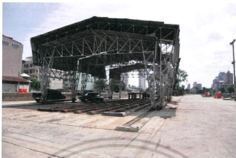
ภาพที่ 1.11 แสดงภาพอาคารซ่อมชิ้นส่วนหลัก
