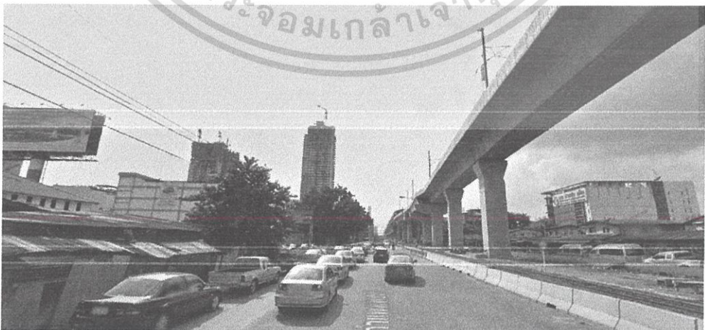
รูปที่ 6.22 แสดงรูปบริเวณ โครงการหมายเลข 3
