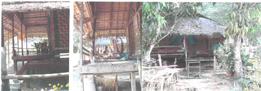
รูปภาพที่ 2-13 ลักษณะชุดผนังยื่นออกจากฝาเรือนหลัก ใช้เป็นที่นั่งพระ
