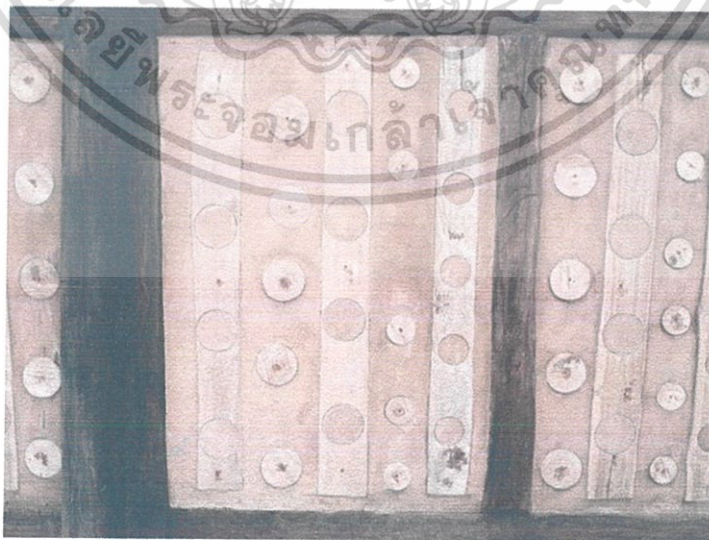
รูปภาพที่ 3-20 ผนังอาคาร ใช้เศษไม้เหลือจากการทำ โครงสร้าง ฝ้าซีก เจาะรู ประกบผนังปูนดินแดง
