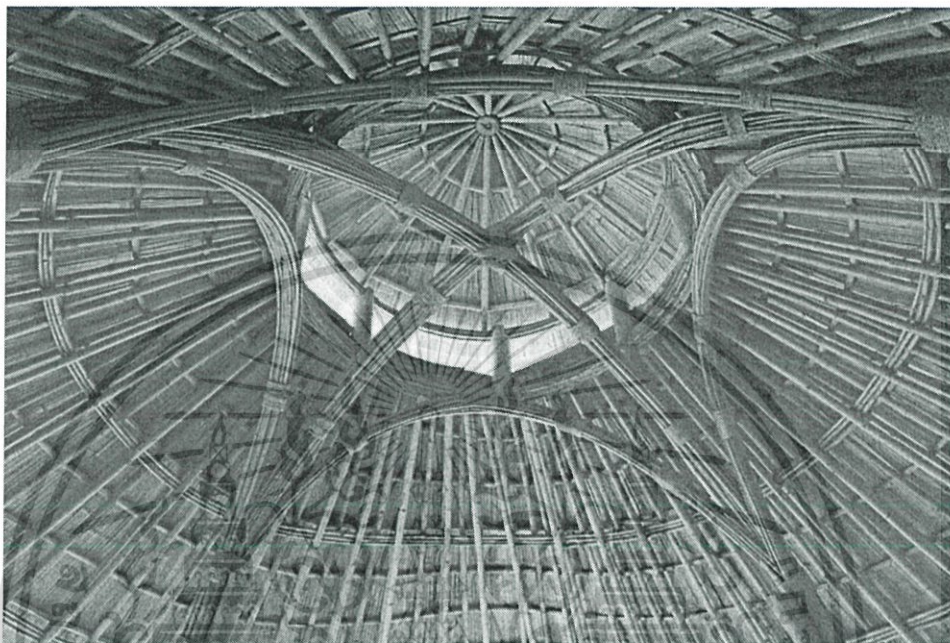
รูปที่ 3-3 รูปแสดง โครงสร้างหลังคาที่ประกอบขึ้นจาก ไม้ไผ่ทั้งหมด
