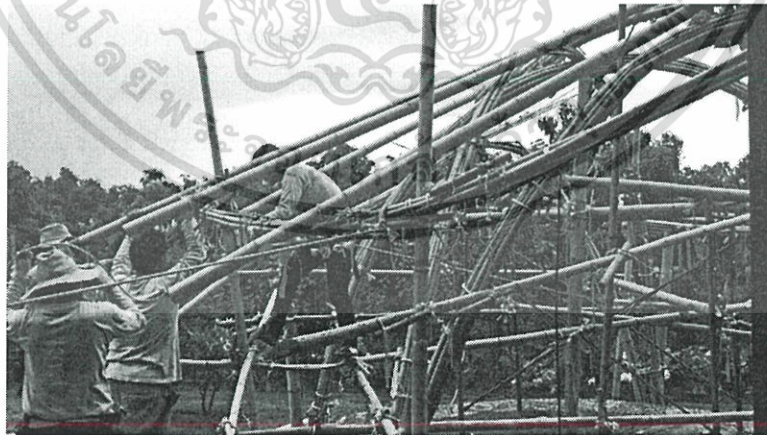
รูปที่ 7-2 รูปตัวอย่างการก่อสร้างอาคารไม้ไผ่โดยใช้เสาแบบ ARCH
