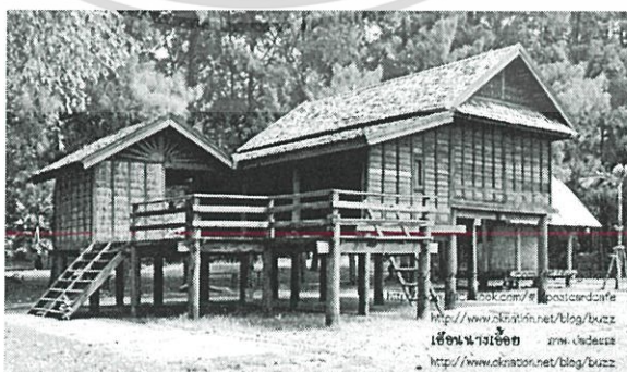
รูปที่ 2-17 รูปแสดงลักษณะเรือนภาคอีสานแบบถาวร
