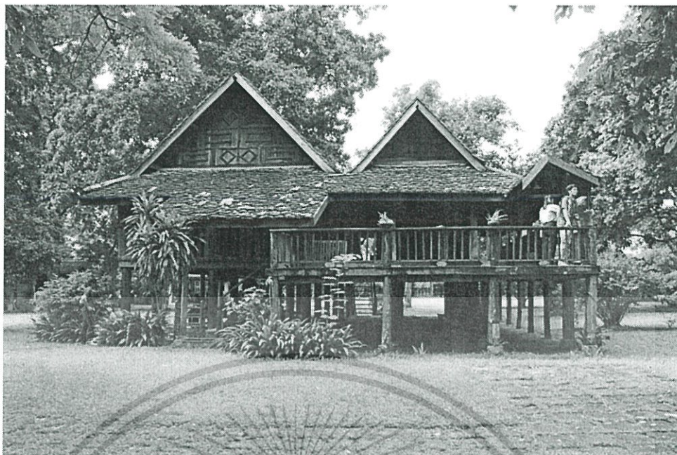
รูปที่ 3-17 รูปแสดงลักษณะเรือนไทลื้อหรือเฮือนหม่อนตุง เป็นเรือนหลังที่สี่ของลำดับการจัดแสดง
