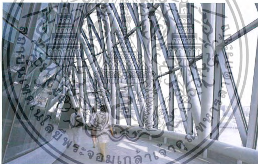
ภาพที่ 3.14 แสดงโถงทางทิศเหนือของอาคารแสดงระบบโครงสร้างของอาคาร
