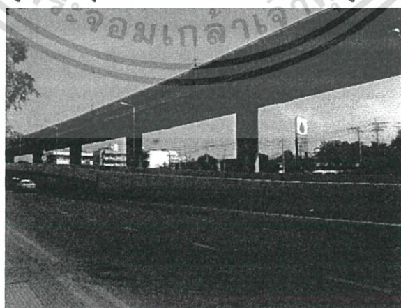
รูปที่ 5-18 มุมมองถนนจากหน้าที่ตั้งโครงการ (ที่มา : ผู้จัดทำ)
