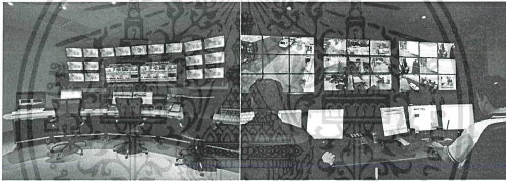
รูปภาพที่ 7-47 แสดงตัวอย่างห้อง Security Control Room
