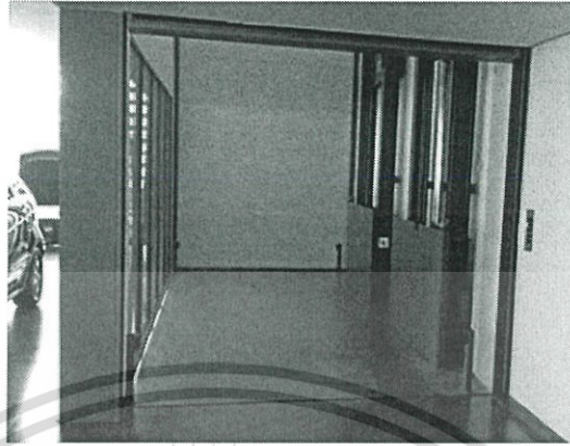
รูปภาพที่ 7-42 แสดงลิฟต์บรรทุกของแบบ Double Column Platform แบบติดตั้งฝั่งเดียว
