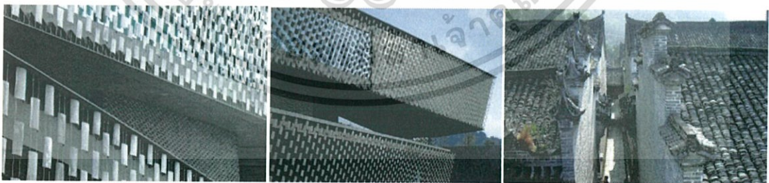
รูปที่ 3.23 ภาพการประยุกต์ใช้กระเบื้องพื้นดินมาออกแบบเป็นผนังชั้นนอกของอาคาร (ที่มา : http://www.archdaily.com/ วันที่สืบค้น : 12 ต.ค. 2559)
