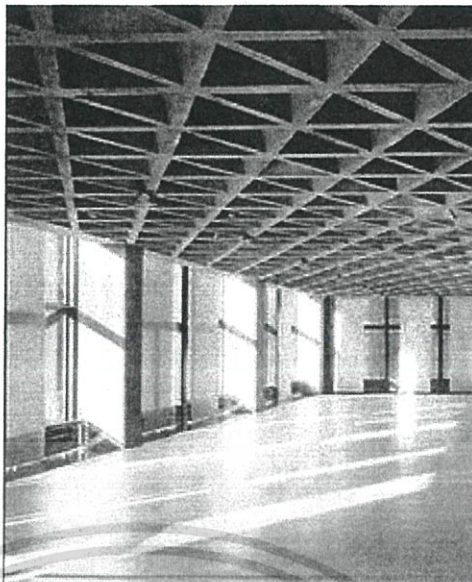
ภาพที่ 7.2 โครงพื้น Waffle Slab
