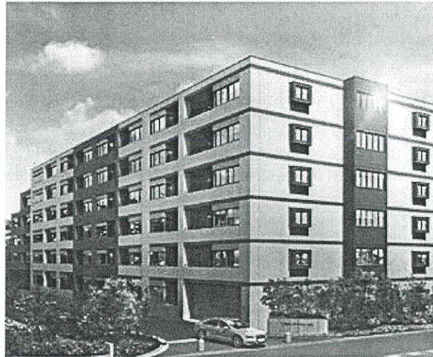
รูปถ่ายที่ 4.45 อาคารห้องพัก F ในโครงการ Smart Community Inage
