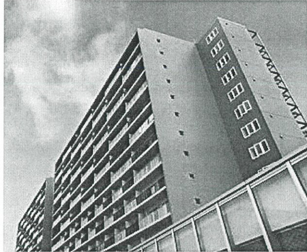
รูปภาพที่ 4.37 อาคารห้องพัก A, B ของโครงการ Smart Community Inage (ที่มา: http://www.smartcommunity.co.jp/ )
