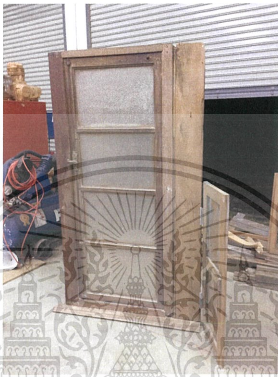
ภาพที่ 15 การประกอบไม้โดยใช้นานพับ
