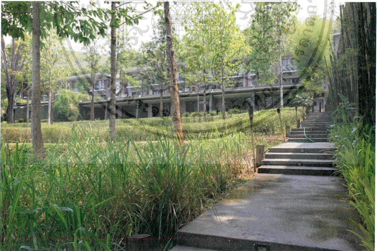
รูปที่ 1.31 แสดงรูปอาคารห้องพัก
