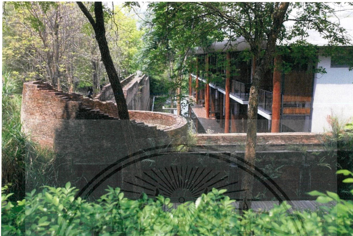
รูปที่ 1.32 แสดงรูปอาคารห้องพัก
