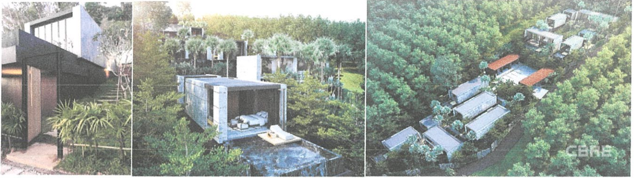
ภาพที่ 1.9.2.7-1.9.2.9 รูปภายนอกอาคาร
