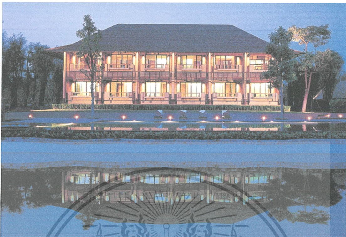
ภาพที่ 2.2.3.1 รูปภายนอกอาคาร
