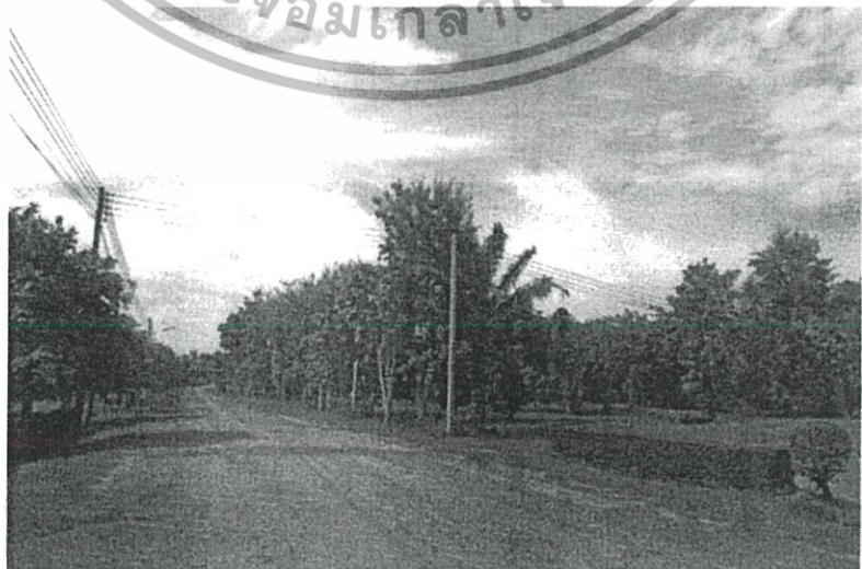
ภาพที่ 6-19 ภาพถ่ายถนนภายในโครงการ
