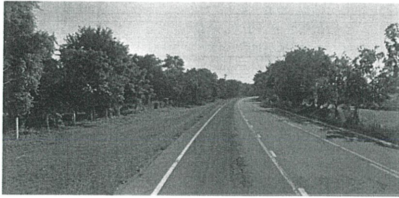
ภาพที่ 6-12 ภาพถ่ายถนนด้านหน้าของโครงการ
