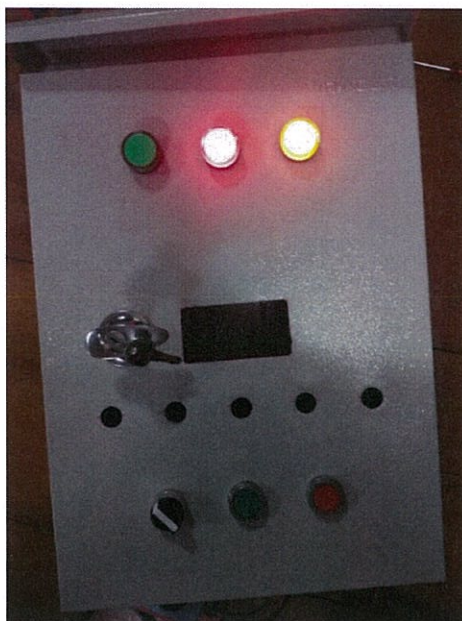
รูปที่ 3.13 การเจาะตู้ควบคุม
