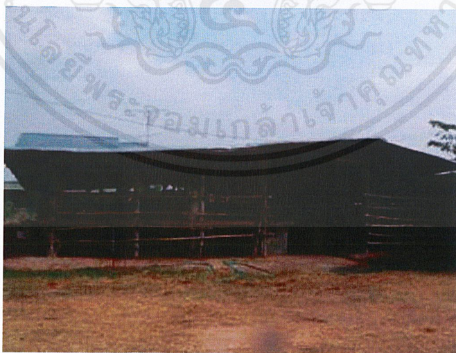
ภาพที่ 4.9 โรงเรือนโคขุนของนายเสริมศักดิ์ อากาศเมฆ
