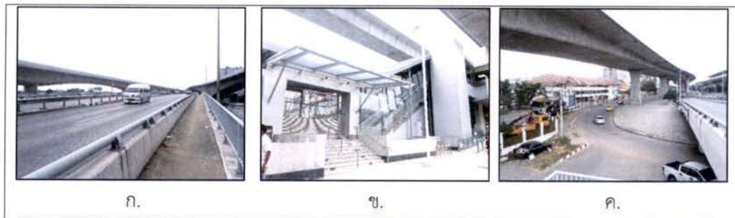
ภาพที่ 5 ก.ถนนบนสะพานพระนั่งเกล้า ข.ทางเข้าสถานีรถไฟฟ้าพระนั่งเกล้า และ ค.ถนนใต้สะพานพระนั่งเกล้า
