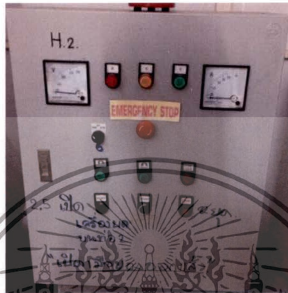
รูปที่ 5.21 ตู้สตาร์ทเครื่องบดเชื้อเพลิงชนิดค้อนเหวี่ยง (hammer mill)
