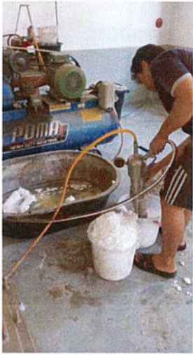
รูปที่ 3.12 เตรียมส่วนผสมคอนกรีตมวลเบา
