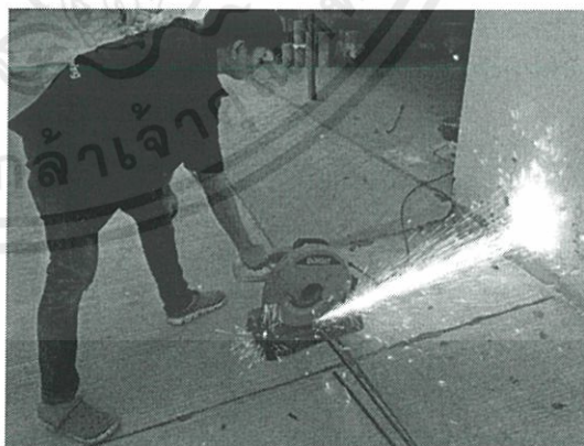
รูป 3.6-3.7 การตัดเหล็กเส้นโดยเครื่องตัดไฟเบอร์
