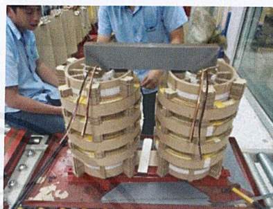
รูปที่ 6 เรียงแกนเหล็กปิดด้านบน
