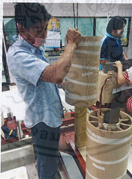
รูปที่ 3.21 สวมขดลวดแรงต่ำลงแกนเหล็ก
