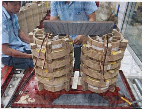
รูปที่ 3.23 เรียงแกนเหล็กปิดด้านบน
