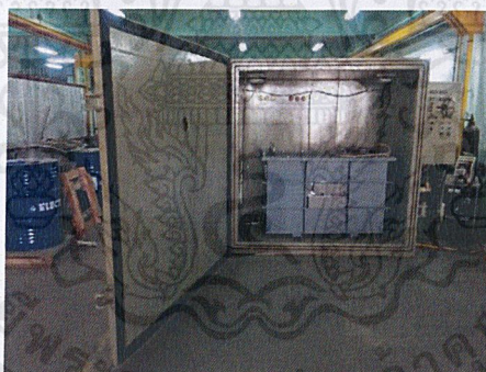
รูปที่ 3.29 นำหม้อแปลงเข้าห้องสุญญากาศและเติมน้ำมัน
