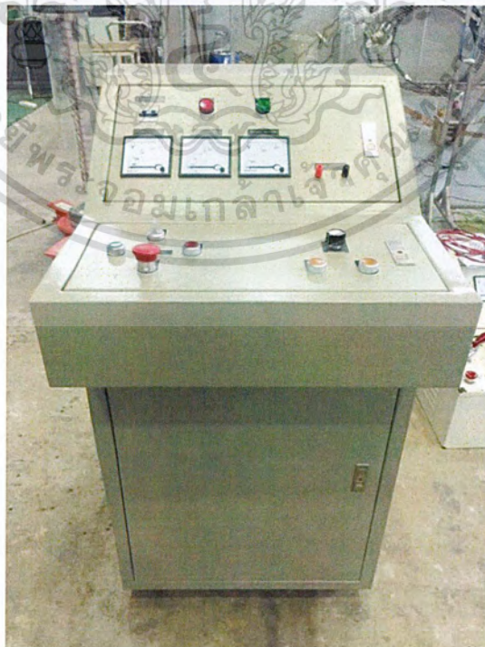
รูปที่ 3.13 ตู้ควบคุมแบบสมบูรณ์จากการประกอบสร้าง
