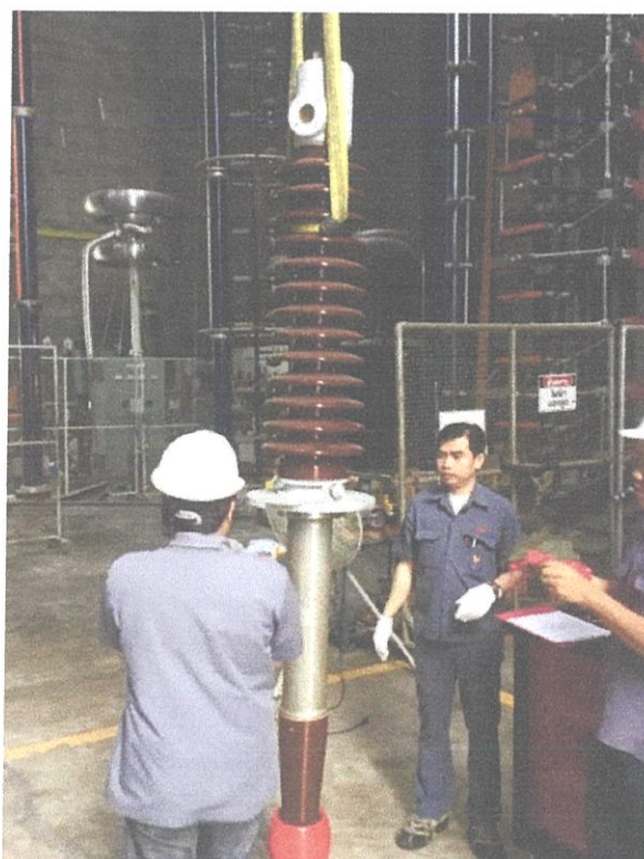
รูปที่ 3.22 บุชชิ่งชนิด OIP condenser bushing พิกัด 123 kV
