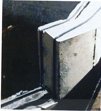
ภาพที่ ข.7 การใส่ยาง Ribbon Sealer ที่รอยต่อด้านบนและด้านข้าง
