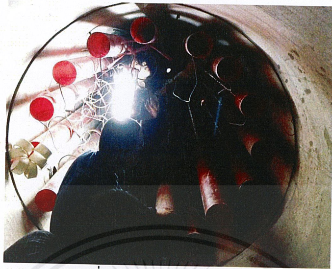
ภาพที่ ค.3 การร้อยท่อร้อยสายไฟฟ้า
