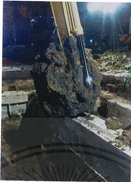
ภาพที่ ข.5 การใช้เครื่องจักรกดชิ้นส่วนลงไป在地面ให้ได้ระดับ
