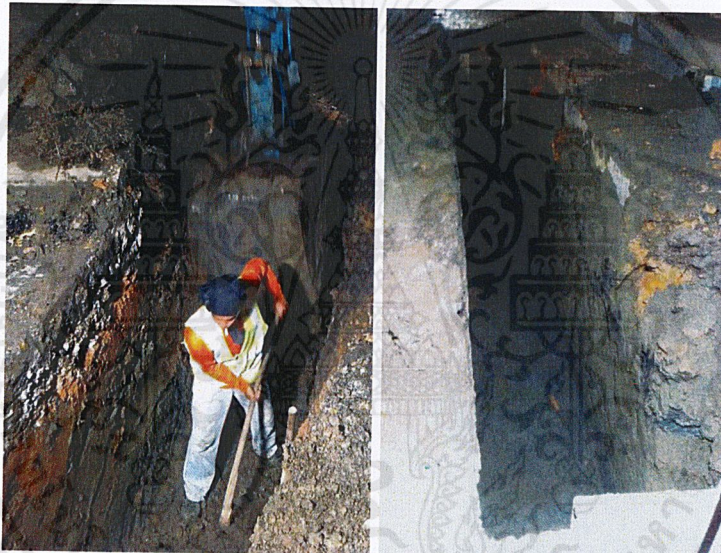
ภาพที่ ข.1 การขุดหลุมและปรับระดับเพื่อวางกำแพงกันดินชั่วคราว และหลุมที่ขุดเสร็จแล้ว
