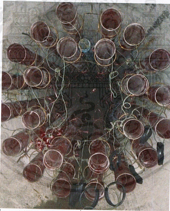
ภาพที่ ค.4 ท่อร้อยสายไฟฟ้าที่ร้อยเชือกเพื่อใช้ลากลูกตุ้มแล้ว
