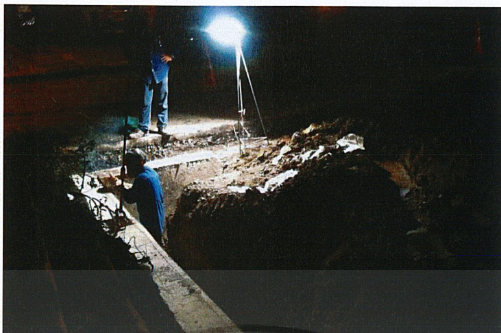
ภาพที่ 2.3 การนำ Guide Collar สำเร็จรูปมาติดตั้งที่หน้างานเพื่อป้องกันไม่ให้บ่อเอียง
