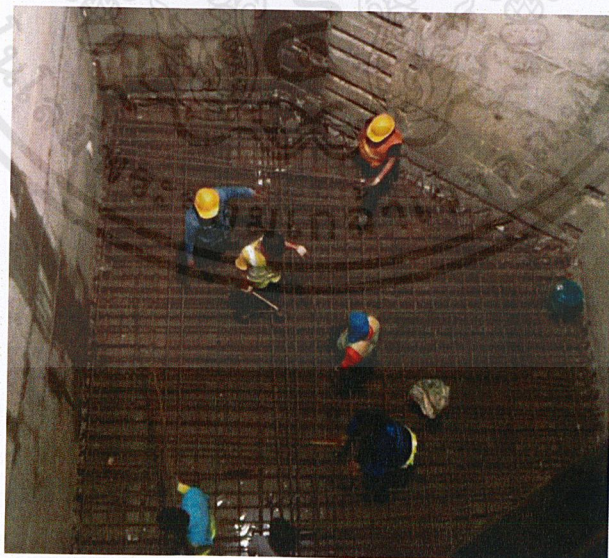
ภาพที่ ข.8 การเสริมเหล็กพื้น
