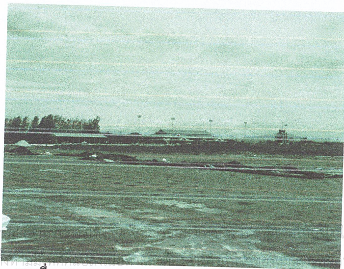
ภาพที่ 5.10 ลานจอด และทางขับใหม่ (ดำเนินการก่อสร้าง)
