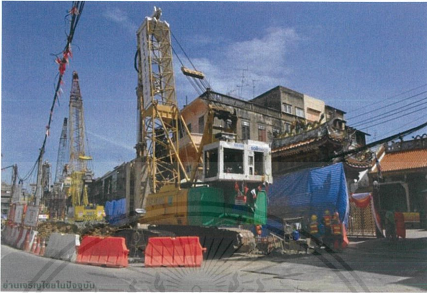
รูปที่ 2.6 ภาพการก่อสร้างสถานีรถไฟฟ้าใต้ดิน
