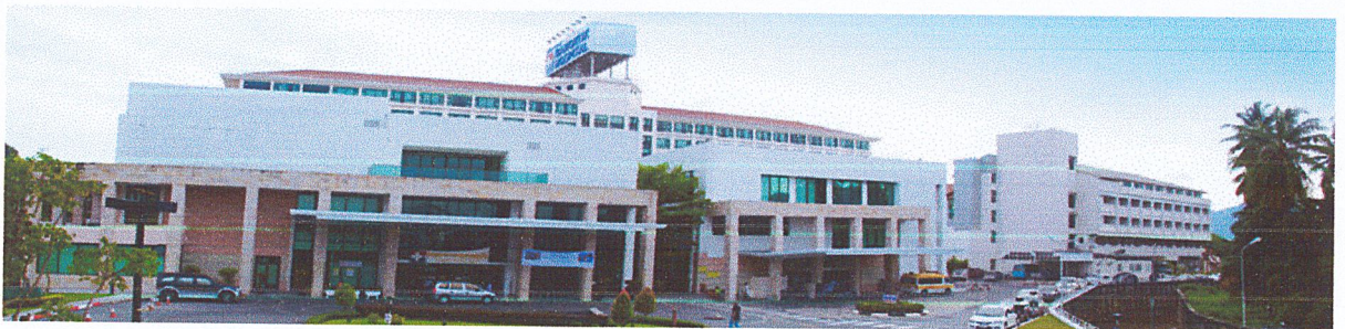
รูปภายนอกอาคารโรงพยาบาลกรุงเทพภูเก็ต
