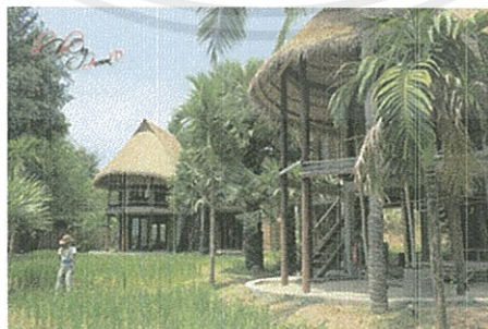
รูปแบบตัวอาคารที่พัก
