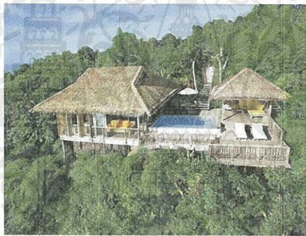
รูปแบบตัวอาคารที่พัก
