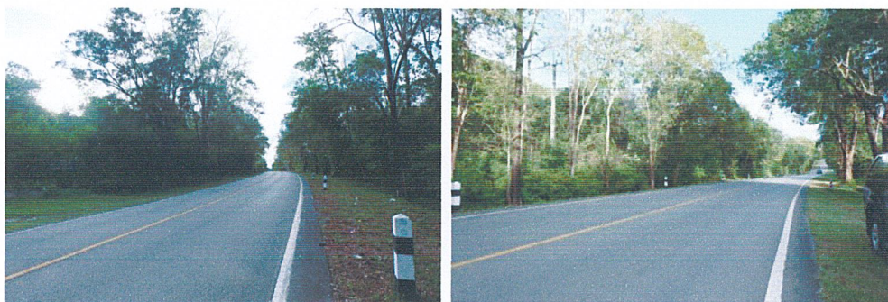
รูปที่ 3.12 ถนนด้านหน้าโครงการ ที่มา ภาพถ่ายเมื่อวันที่ 2 ตุลาคม 2558
