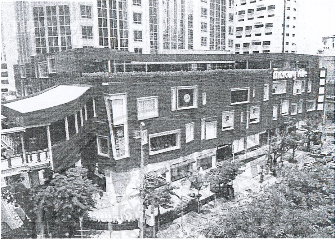
ภาพที่ 48 อาคาร The Mercury Ville
