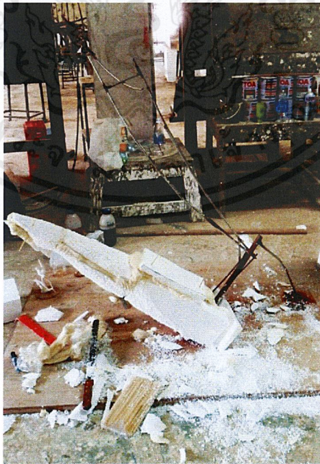
ภาพที่ 3.16 เชื่อมเหล็กเพื่อเป็นโครงสร้าง
