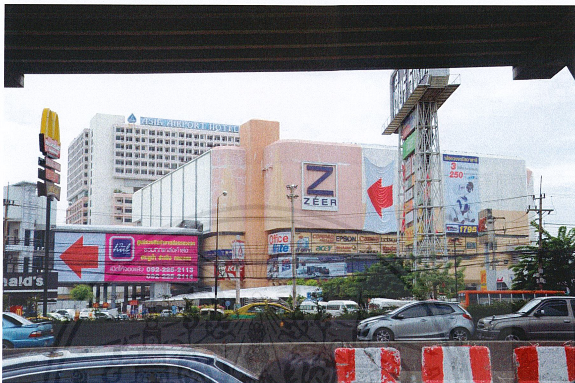
รูปที่ 4.2 ลักษณะภายนอกตัวอาคาร
