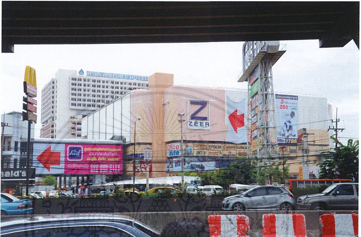
รูปที่ 1.6 ลักษณะภายนอกตัวอาคาร
