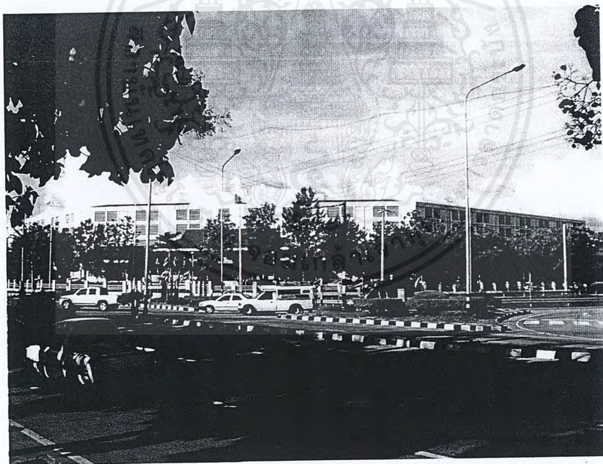
ภาพที่ 2-3 สภาพภายนอกอดีตเรือนจำกลางจังหวัดเชียงใหม่
