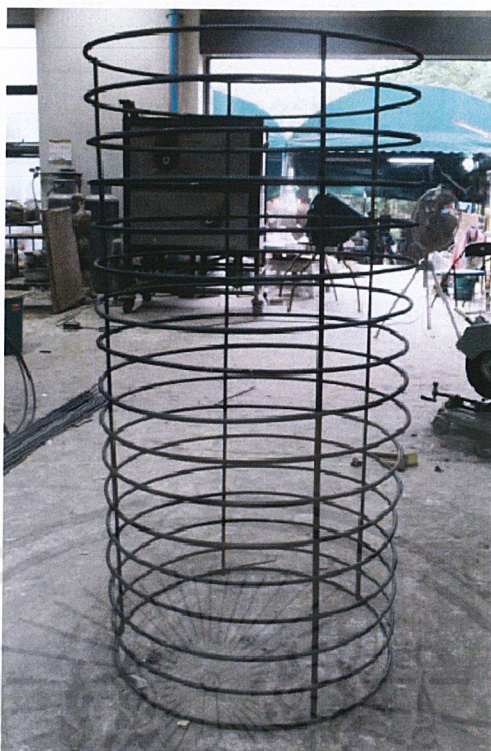
ภาพที่ 79 ตรวจสอบระยะห่าง ระหว่างช่องของตัวงาน
