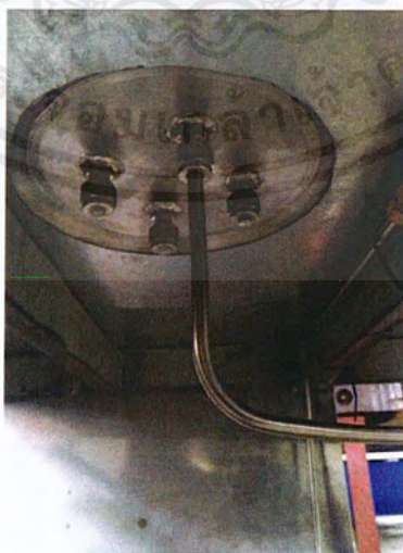
รูปที่ 25. แสดงบลายด์แฟลนค์หลังเจาะ
