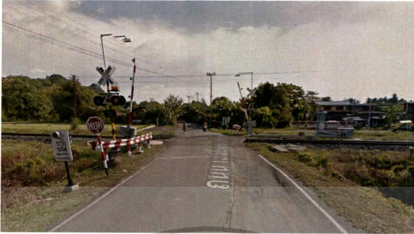
รูปที่ 1.10 ทางแยกทางร่วมที่มีเครื่องเตือนภัยรถไฟ
