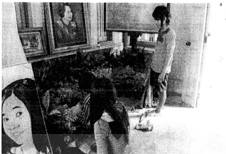
ภาพที่ 2.111 การติดตั้ง การตกแต่งบริเวณภายในอาคารแสดงนิทรรศการหอศิลป์ วิทยาลัยอาชีวศึกษาฉะเชิงเทรา ที่มา : ออกแบบโดย นายนิพนธ์ ชิงชัย
