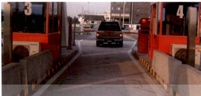
ภาพที่ 3.7 การตรวจจับด้านหน้า - ม่านแสง (OB) และ อุปกรณ์เหนี่ยวนำไฟฟ้า (Loop)
