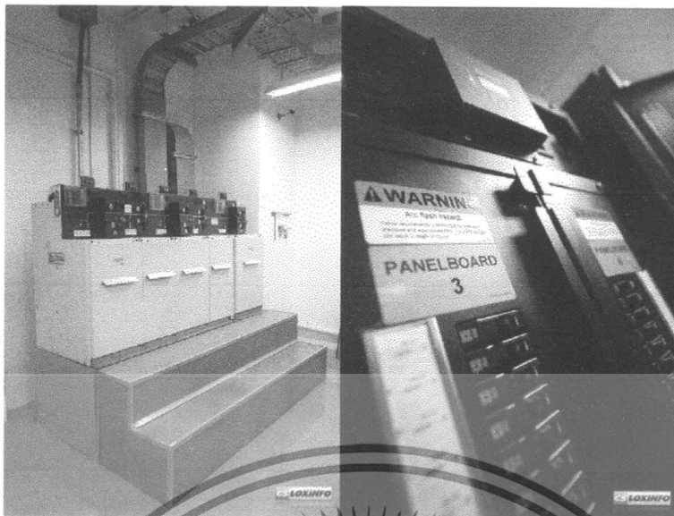
ภาพที่ 3.4 อุปกรณ์จ่ายกระแสไฟฟ้าต่อเนื่อง (UPS) ที่มา : บริษัท ซีเอส ลีอ็อกอิน โฟ จำกัด (มหาชน). 2556
