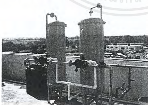
ภาพที่ 6.5 เครื่องทำน้ำอ่อน (Water Softener) ใช้บำบัดน้ำเพื่อลดความกระด้างก่อนนำน้ำไปใช้
