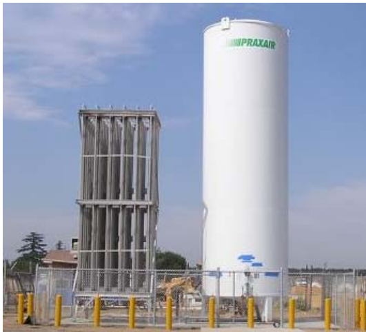
ภาพที่ 2.8 เครื่องมือเปลี่ยนสถานะของก๊าซที่ใช้ตามปั๊มเติมก๊าซ เอนจิวิให้กับรถยนต์ ที่มา : http://en.wikipedia.org/wiki/Evaporator
