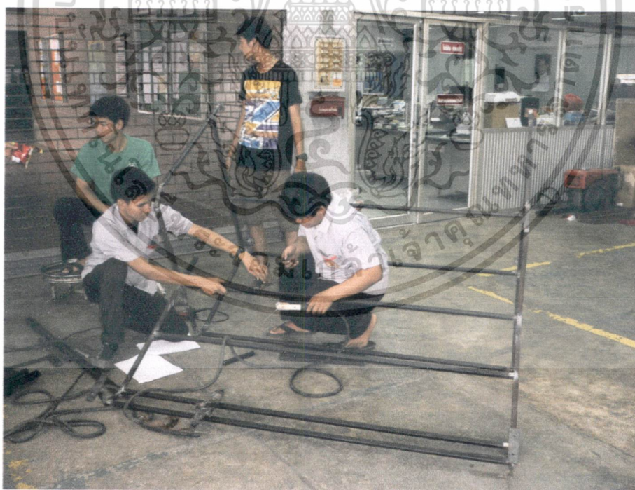
การเชื่อมชิ้นโครงยึดตัวโมเดลเวอร์เนียร์คาลิปเปอร์
